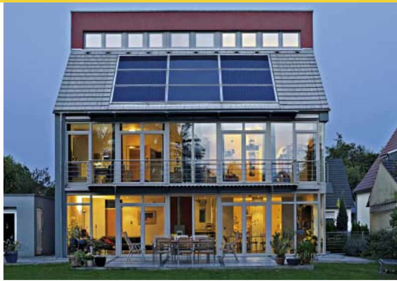
Einfamilienhaus mit Solaranlage zur Wärme- und Stromgewinnung
