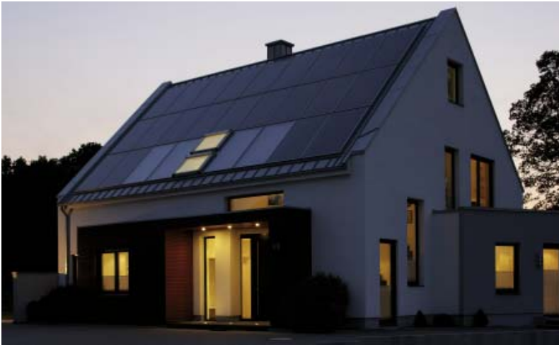
Eine Solarthermieanlage mit vier Schüco Tieftemperaturkollektoren übernimmt in Verbindung mit einer Wärmepumpe die gesamte Gebäudeheizung
