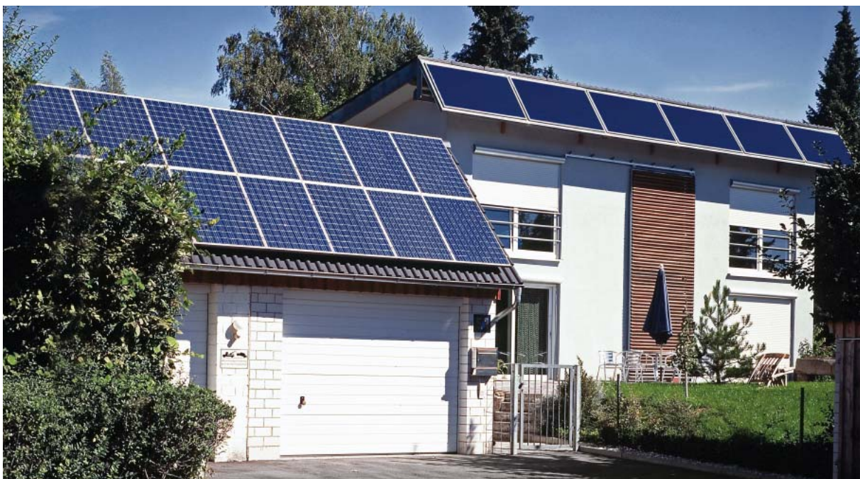
Garage mit Aufdachmontage
