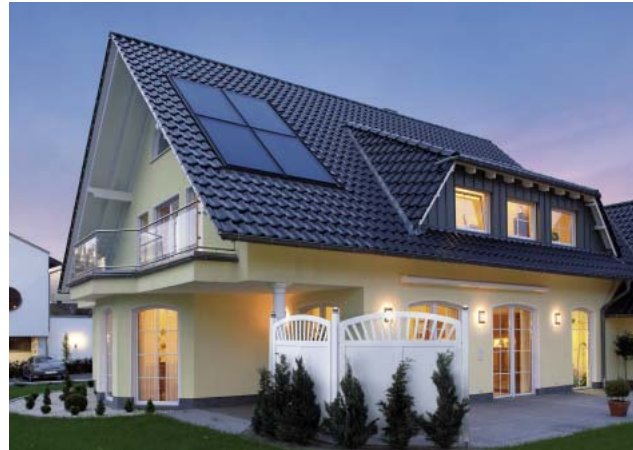
Solarthermieanlage zur Heizungsunterstützung
