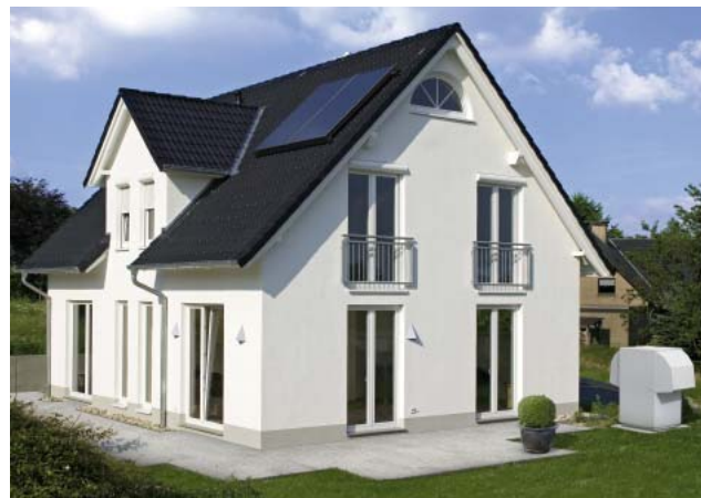
Luft/Wasser-Wärmepumpe mit Solarthermieanlage
