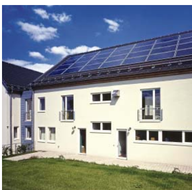
Mehrfamilienhaus mit Photovoltaikanlage
