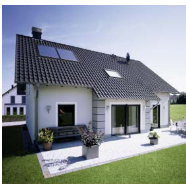
Einfamilienhaus mit Solarthermieanlage
