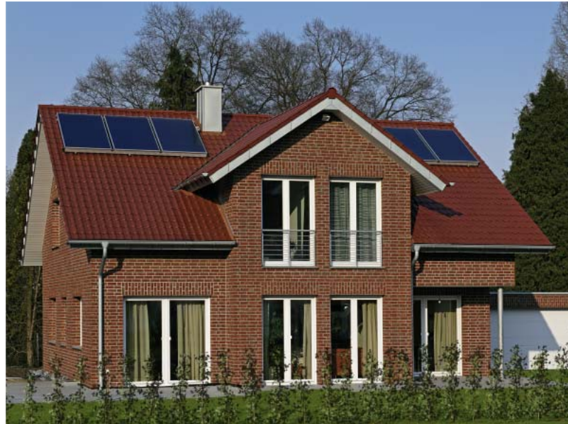
Einfamilienhaus mit Schüco Sole/Wasser-Wärmepumpe HPSol
